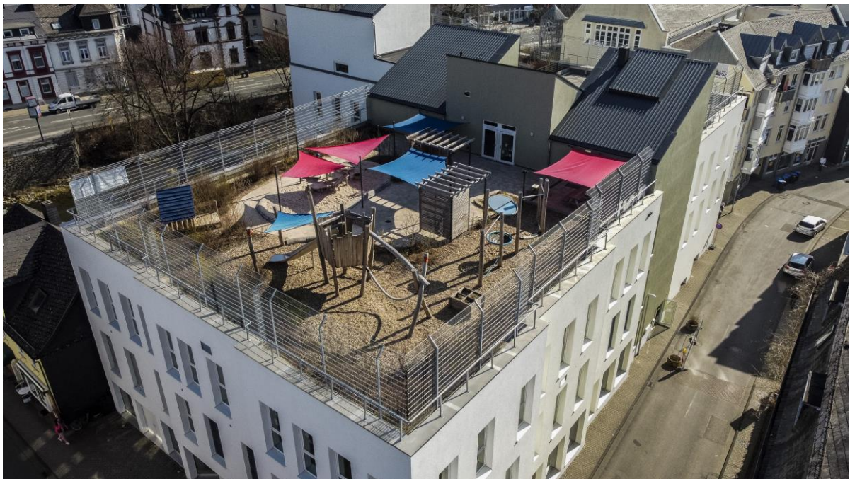
Dachterasse im Ü3 Bereich
